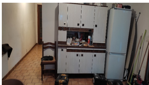
A l'intérieur du futur logement
