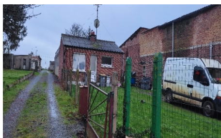
Devant le futur logement
